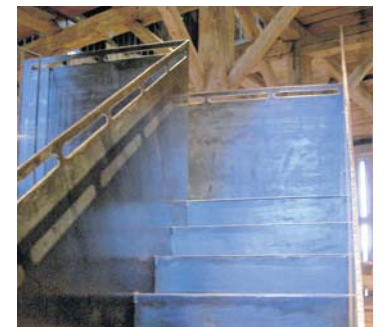
Die neue Treppe in der Artene.
